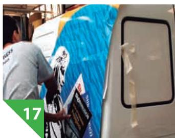
Inicie a adesivação de apenas uma parte da imagem. Porém, antes de iniciar esse procedimento, marque a posição das demais partes com fita adesiva. As fitas servirão de referência para o reposicionamento das demais peças
