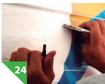
Depois de adesivar qualquer uma das partes, realize o acabamento, verificando se há bolhas (que podem ser furadas com o auxílio de um estilete)
